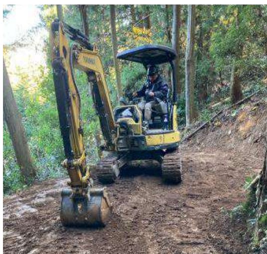
水道施設管理道の重機借上整地作業
